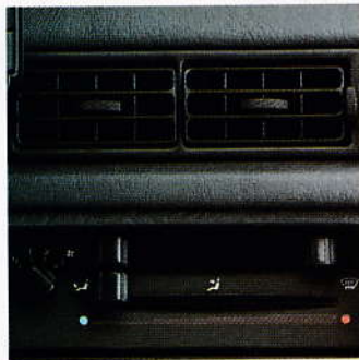
Heizungs- und Belüftungssystem mit 3stufigem Gebläse.
