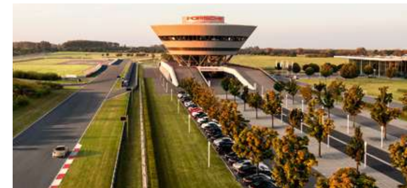
Circuit et Centre Clients Porsche
