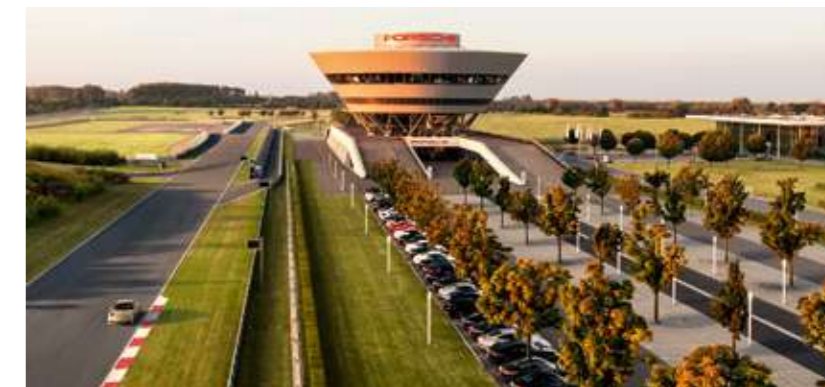
Circuit et Centre Clients Porsche
