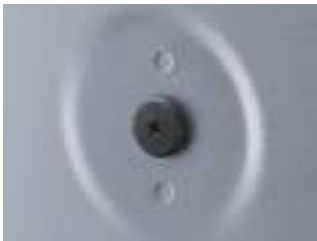
デッキサイド部
