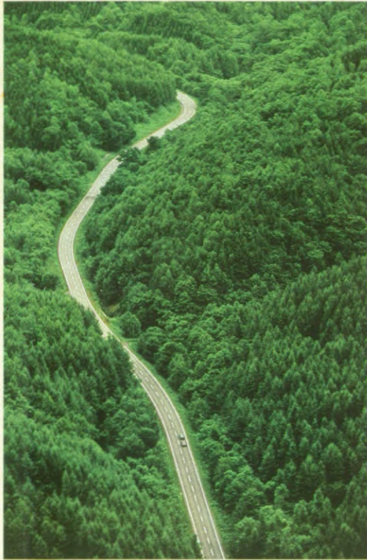
Testbaan met hi-tech faciliteiten.
