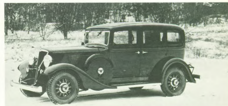
Met de PV 659 kwam een einde aan de periode van hoekige stijl. Dit was een ontwikkeling van oudere modellen, waar het grootste nieuws de motor was. Een grotere cilinderinhoud leverde 80 pk op. (PV 658-659, 1935 – 1938).
